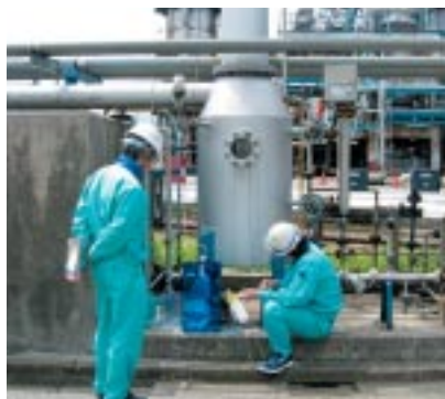
メチルエチルケトン製品タンクから排出されるガスを水吸収装置で処理し、大気への排出を抑制している状況を外部分析メーカーにて実測
