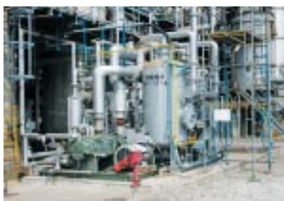
*ベンゼン回収設備 ベンゼン船への荷積の際、大気に放出されるベンゼンを当装置で回収しています。(2004年12月稼動)
