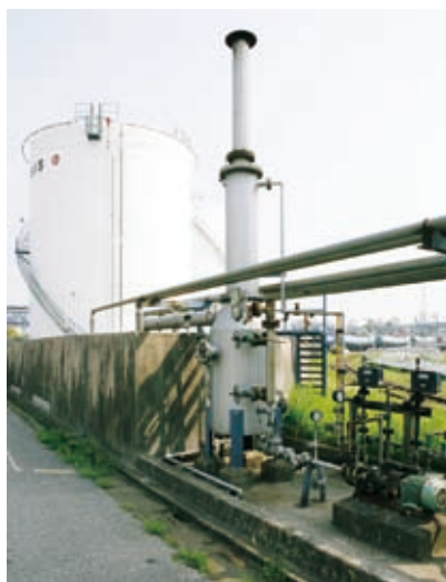
メチルエチルケトン製品タンクから排出されるガスを水吸収装置で処理し、大気への排出を抑制している状況を外部分析機関にて実測
