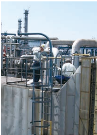
*排ガス(NOx, SOx)定期測定 ボイラーの煙道における排ガス定期測定状況
