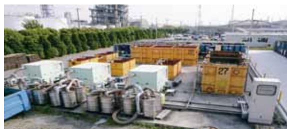
地下水揚水曝気処理施設
