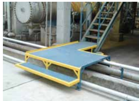
階段の降口を平らな歩廊とし、激突または転倒のリスクが軽減できた
