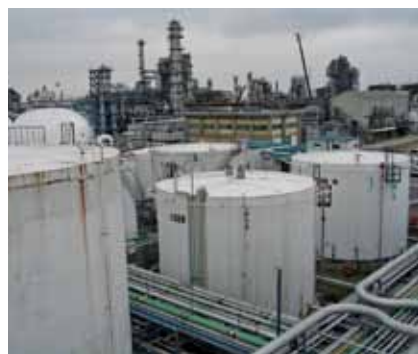
内部浮き屋根式タンク (インナー・フロート・タンク)
