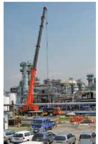
復旧中のアルコールケトン装置
