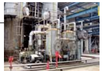
③対応 ベンゼンリターンガス回収装置
