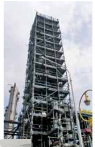
▲タワーの外面腐食検査の様子
