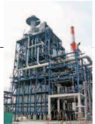
分解炉煙突とボイラー煙突(千葉工場)
