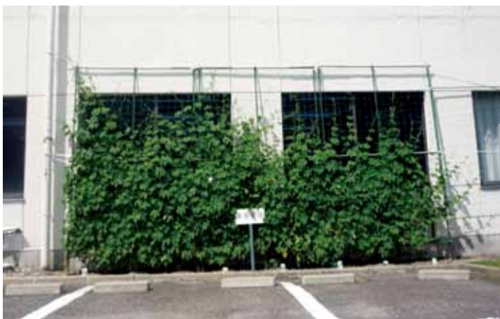
▲ゴーヤの植樹によるグリーンカーテン（四日市工場）
