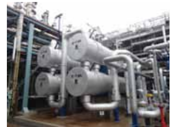
▲新設した熱交換器（4基）
