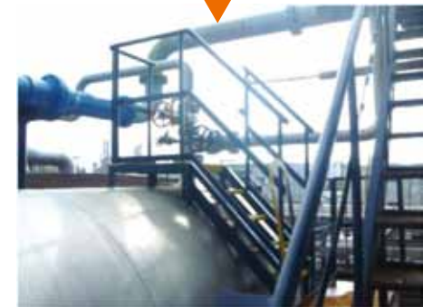
協力会社の危険予知活動に基づく改善提案事例 (階段に手すりの設置)
