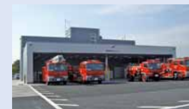
消防指令センター
