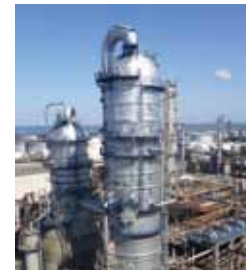
4EP F-101 工事後
