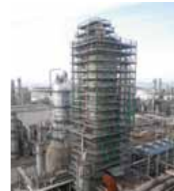
4EP F-101 外面腐食工事の様子
