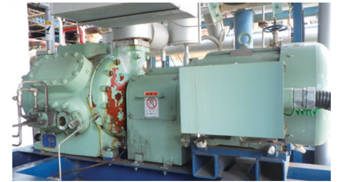
ヘキサンの回収装置の冷凍機ユニット(千葉工場・ポリエチレン製造課)
