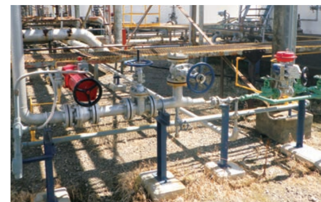
ガソリタンクのベントガス(放出口ガス)をフレアスタックに送気するための「ガスエジェクター」(フレアスタックに回収したガスを処理することで大気放出を削減する)
