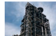
2020 第3エチレン製造装置の大型分解炉への更新工事完了
