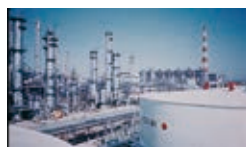
1969 第3エチレン製造装置の完成
