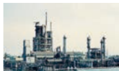
1964 第1エチレン製造装置の完成
