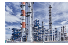
2022 プロピレン精留設備の完成
