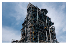
2020 第3エチレン製造装置の大型分解炉への更新工事完了
